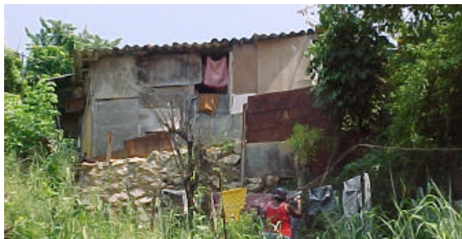
Peligrosa cercanía de las viviendas a las márgenes del Río.
