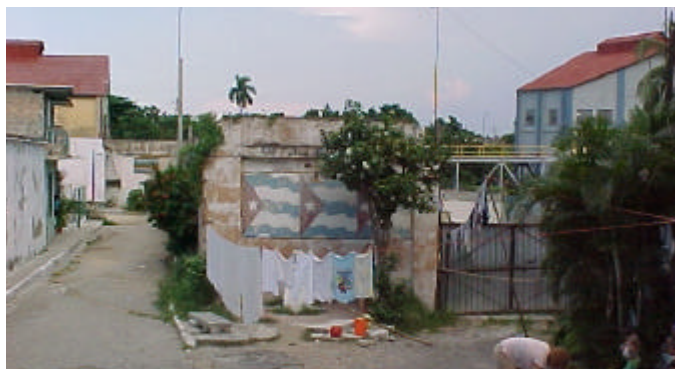
Deterioro de la infraestructura vial, segundo hábitat popular.
