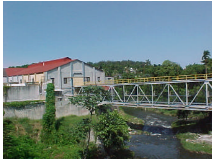
Río Almendares, columna vertebral de la deteriorada urbanización.
