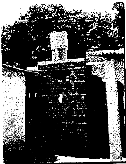
CAIXA D'ÁGUA DOMICILIAR 250 LITROS
