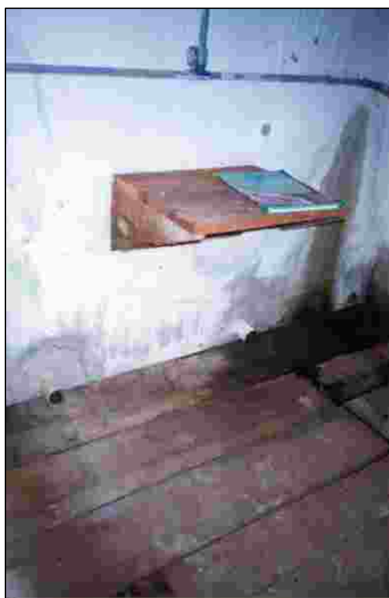
Foto 1 y 2. Vista interior del ambiente donde se reinstalará el sistema de desinfección por goteo
