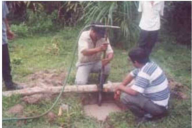
Foto ITDG: Instalación de una bomba manual, Moyobamba
