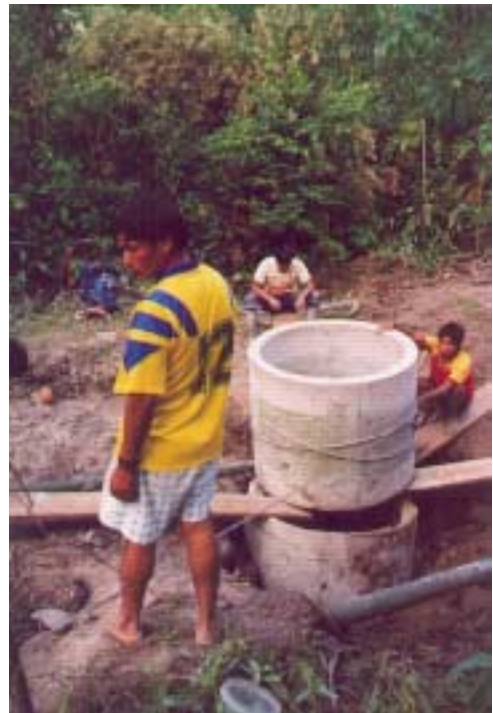
Foto ITDG: Construcción de pozos de concreto, Moyobamba
