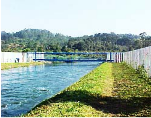
Figura 8: Canal de chegada na várzea do reservatório Guarapiranga, onde é despejada a água proveniente da Billings.
