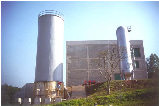
Figura 12: Vista da elevatória principal, com RHO à direita e Chaminé de Equilíbrio à esquerda.
