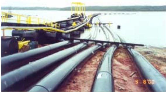
Figura 5: Tubulações de PEAD de 800mm de diâmetro e 390m de extensão.
